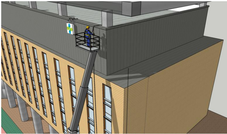
〈전면 외벽 방수〉
