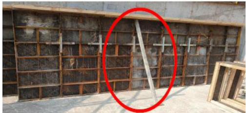
대형거푸집 인양 시 전용 인양고리 사용, 임시 거치 시 버팀대로 지지
