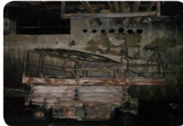
가설전등 스파크로 인한 우레탄폼 화재로 13명 사상
