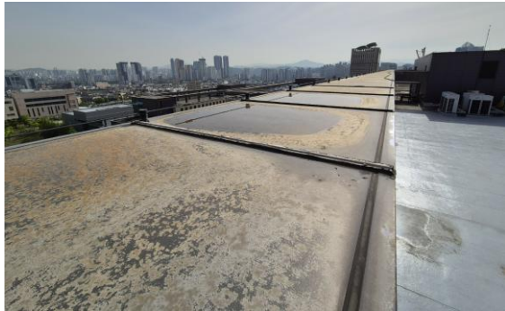
〈옥상 조형물 상부 복합판넬 코킹 전경〉
