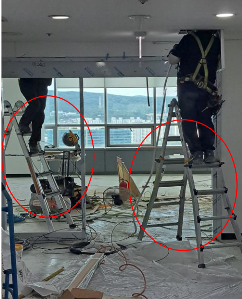
단독작업으로 이동식사다리가 넘어지면서 떨어짐 위험
