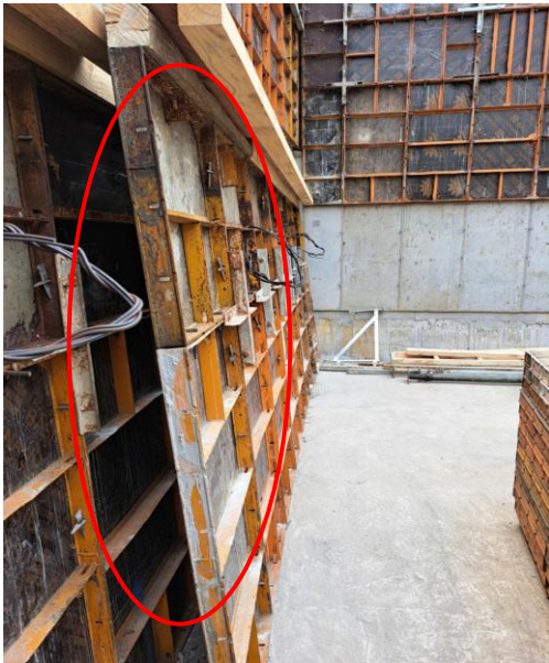
대형거푸집 인양 시 인양고리 불량으로 낙하 위험, 거푸집 임시 거치 시 전도 위험
