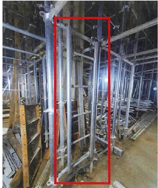
시스템동바리 해체작업 시 상하 이동할 수 있도록 승하강 통로 설치
