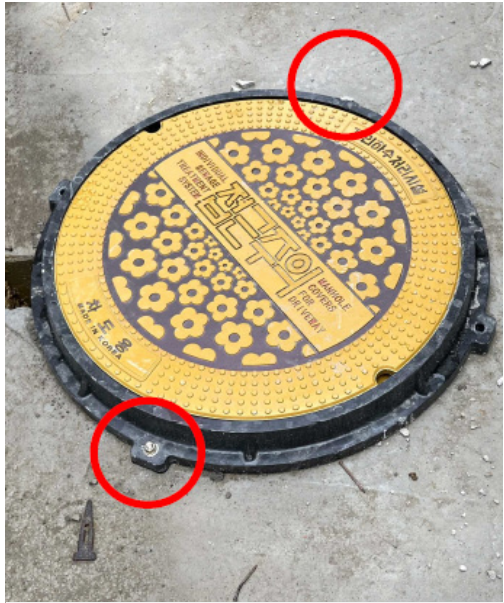
개구부 규격에 맞는 덮개를 고정하여 설치
