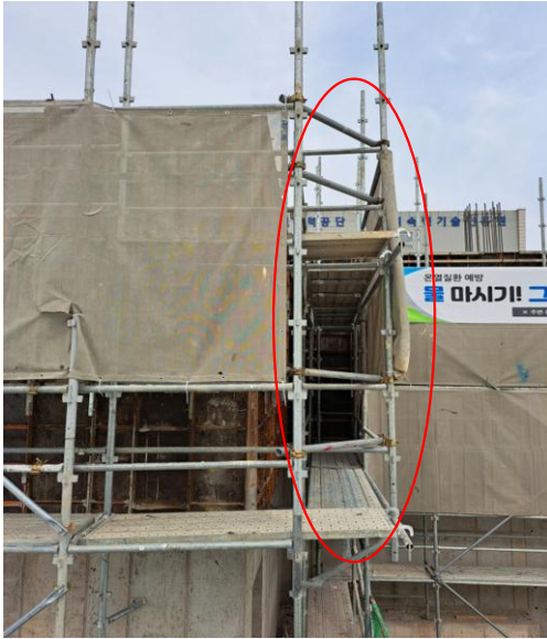
코너부 시스템비계 작업자가 안전난간 넘어 이동 위험
